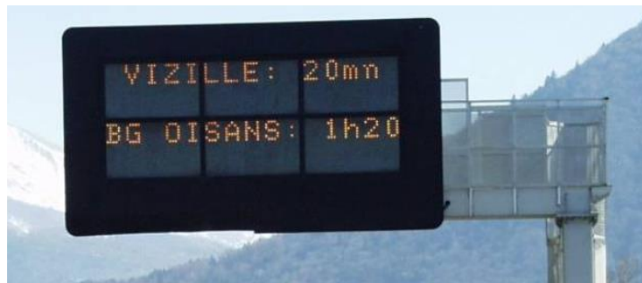
Figure 38: exemple d'affichage de temps de parcours sur la N85 (source : DIR CE)
